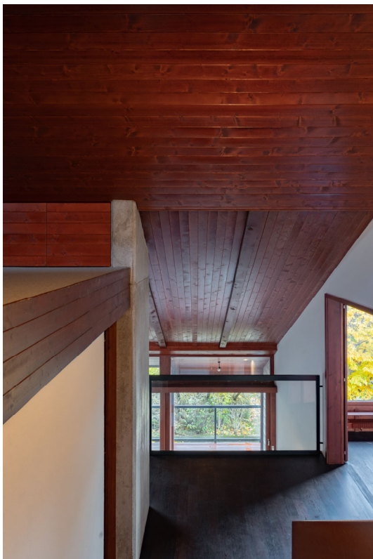
Isolation de la toiture | après
